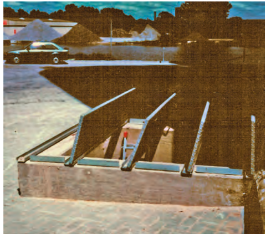
Bild 38: Notausstieg aus einem Silokeller, der gleichzeitig als Druckentlastung dient. (Prof. Siegfried Radandt)
