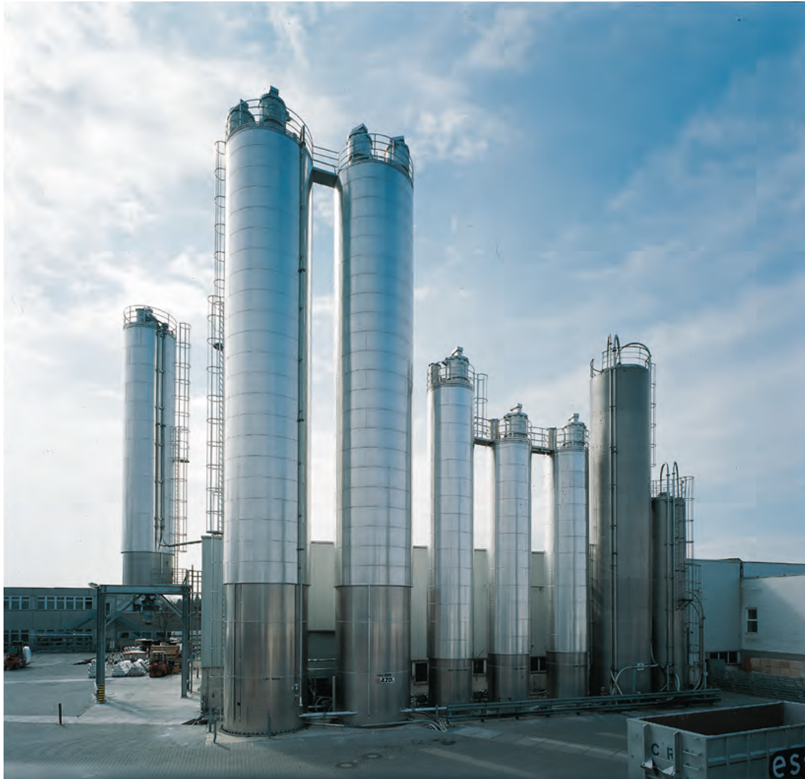
Bild 1: Siloanlage mit Außensilos (AZO GmbH + Co. KG)
