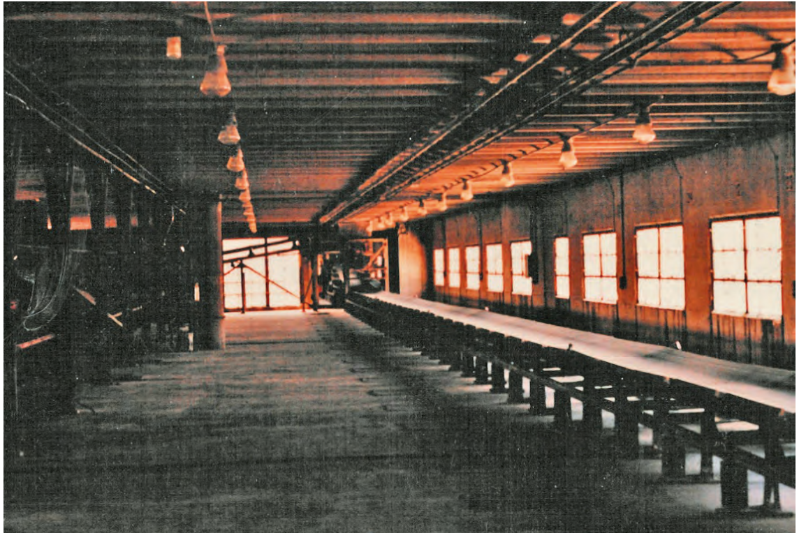
Bild 40: Siloboden mit Förderband und splitterfreien Fensterelementen als Druckentlastung (Prof. Siegrfried Radandt)
