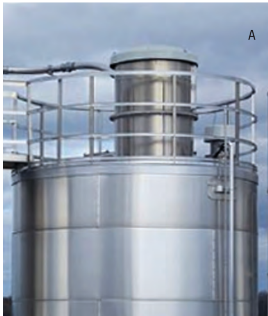
Bild 15: Silo Be- und Entlüftungsfilter als Spülluftfilter ausgeführt (A, B: Schlauchfilter, C: Taschenfilter) (A, B: AZO GmbH + Co. KG, C: WAM GmbH)
