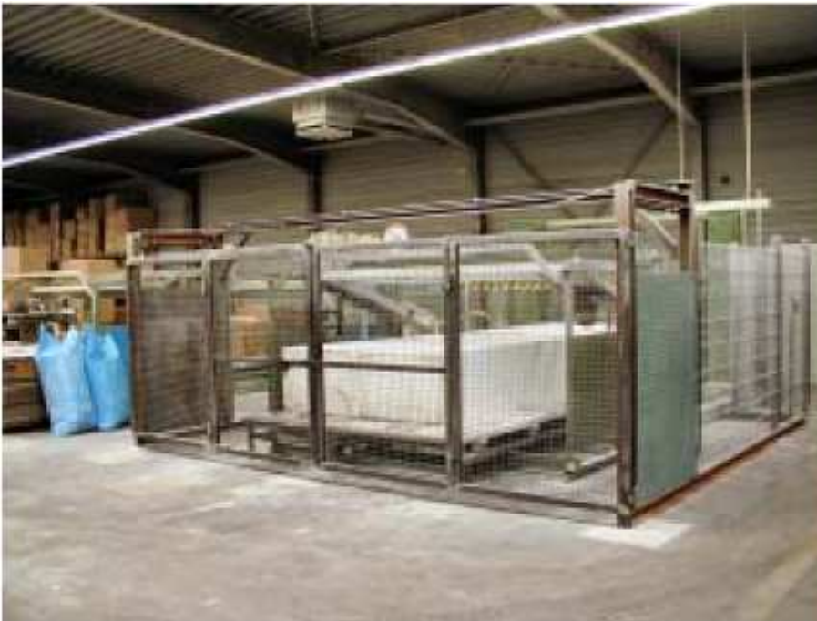
Abbildung 4: Beispiel für eine nachträglich mit einer Umzäunung gesicherten Drahtschneidemaschine. An der Beladeseite ist eine verriegelte Schutztür.
